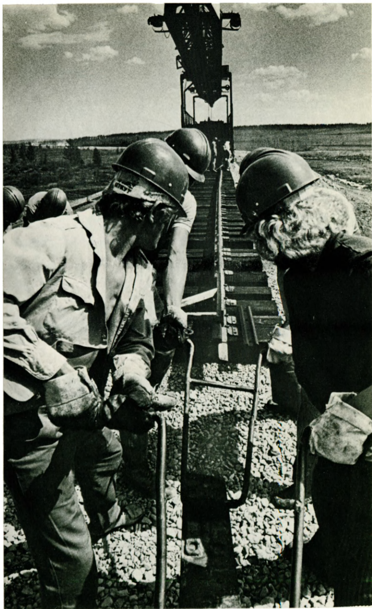
Укладка рельсового звена БАМа
