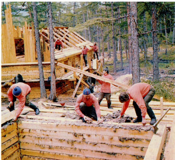
Растут стены домов
