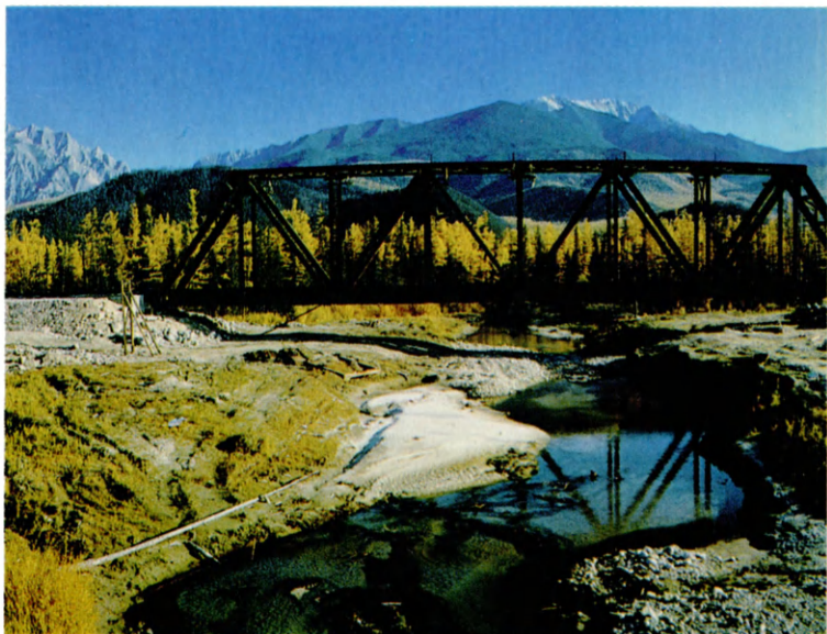
Участок строящегося БАМа
